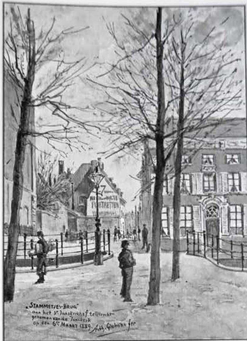
A. Grolman, Stammetjesbrug aan het St. Janskerkhof, 6 maart 1889. Het hoekpand Nobelstraat/Drift was al afgebroken in 1878. Hiermee werd een begin gemaakt met de verbreding van de Nobelstraat. De tekening laat zien hoe smal de straat oorspronkelijk was (ca. 4,5 meter) ten opzichte van de huidige breedte (12 à 14 meter). HUA, Collectie Beeldmateriaal
